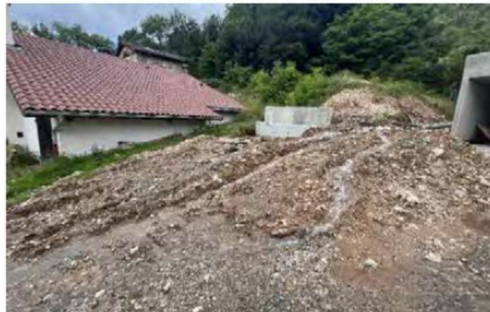
Photo 44 : Diffusion des écoulements sur la parcelle en construction (photo RTM, 10/06/2024)
