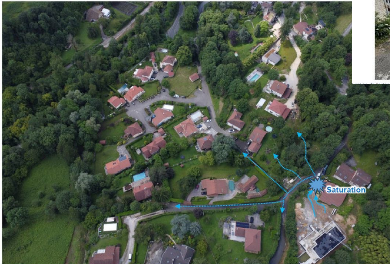
Photo 46 : Cheminement des écoulements et ruissellements de surface (photo RTM, 10/06/2024)
