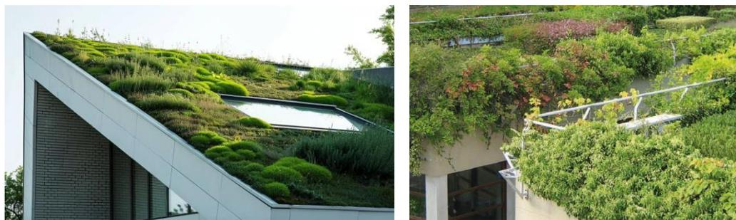
Figure 65. Exemple de végétalisation pour une toiture en pente et une toiture plate
