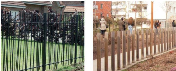
Figure 48. Deux exemples de séparation perméable à la petite faune
