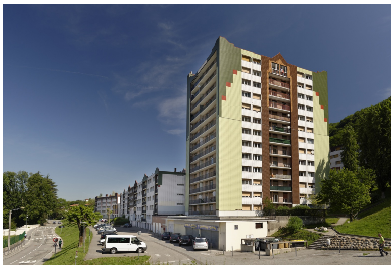
Illustration 3: Bourg-vieux phase 1 des travaux de réhabilitation
