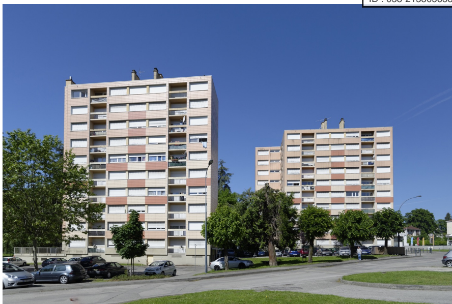
Illustration 2: Baltiss, tours à démolir
