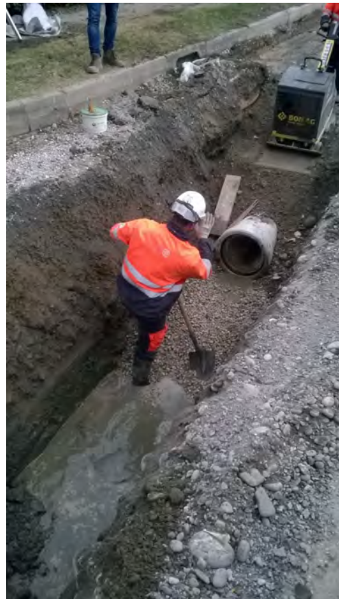
Pose de collecteur Assainissement avec drainage
