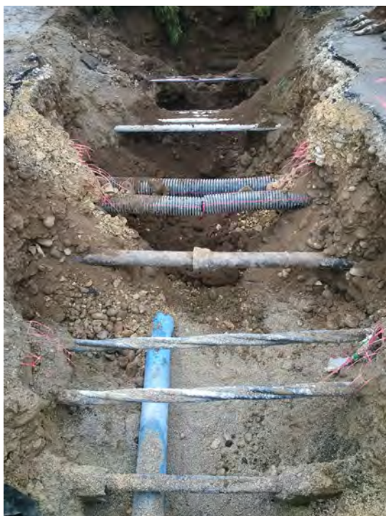
Encombrement possible lors de pose de conduite
