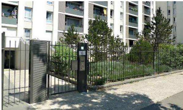
Exemple de serrurerie en limite d'espace collectif
