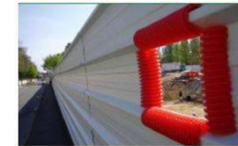
Limitation des poussières : goulotte + bâche Et protection acoustique
